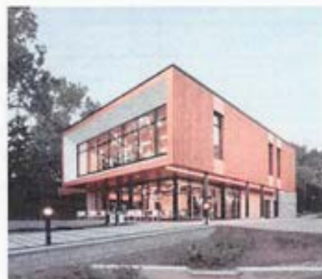
Fig. 270 Premier bâtiment net zéro à Montréal, Akurto à Cartierville (Source: Sironen)
