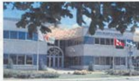
Fig. 228. Centre des loisirs de Saint-Laurent implanté sur la rue Grenet au sud de l'axe 700 (Source: Ville de Montréal)
