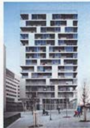
Fig. 265. Bâtiment phare, Paris, France (Source : Anoma Moulin, Lottin et Hellemecker)
