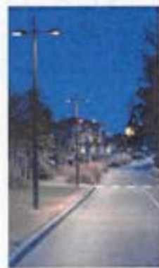
Fig. 173 Éclairage public (Source: V&A et Part)
