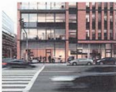
Fig. 266 Façade transparente en relation avec le domaine public, Hambourg, Allemagne (Source: DMF Architects)
