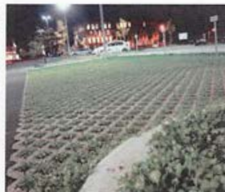
Fig. 298 Revêtement perméable, Technopôle Angoulême (Source: Garenne Roux)
