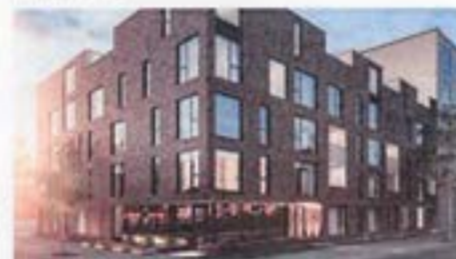
Fig. 252 Immeuble à logement multiple mixte de 5 étages, Rosemont-La-Petite-Patrie, Montréal (Source: Gagné Habitat/UR)
