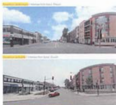
Fig. 77 Réaménagement du boulevard Laurentien Source: StreetView
