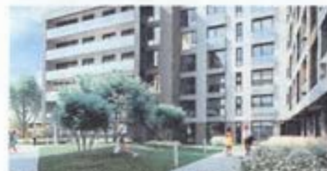
Fig. 124 Immeuble à logements multiples, Ahlers Castelnuovo, Montréal (Source : Guide Habitatmix)
