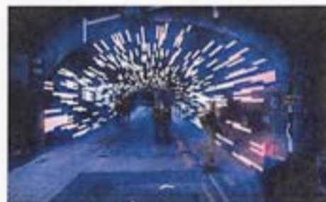
Fig. 216. Mur et plafond de viaduc peints avec bandes lumineuses interomises, Doe Mj Maar Zuid Tunnel, Heerle, Pays-Bas (Source: Bureau)
