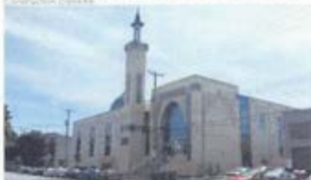
Fig. 222. Centre atomique du Québec (CAQ) implanté sur le chemin Laval à proximité de la rue Grenet (Source: Promoteur Reg)
