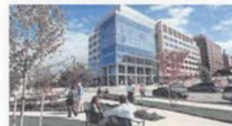
Fig. 135 Pôle d'emploi, Baltimore, États-Unis Crédit: Gensler/Danforth
