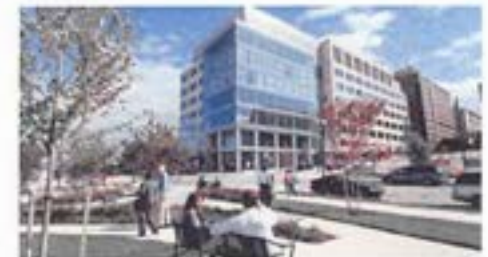
Fig. 135 Pôle d'emploi, Baltimore, États-Unis Source: HOK / 2010
