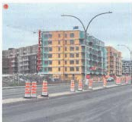
Fig. 4. Projet Curbside Condo en construction. (Source : UrbanBC2)
