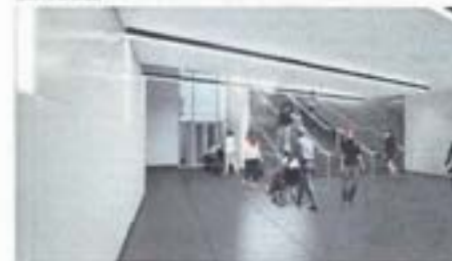
Fig. 297 Édicule de métro Verdôme de la STM, aménagé pour assurer l'accessibilité universelle (Source: STM)
