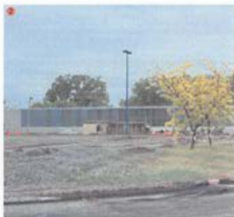
Fig. 5. Station du REM Bois-Franc en construction. (Source : UrbanBC2)
