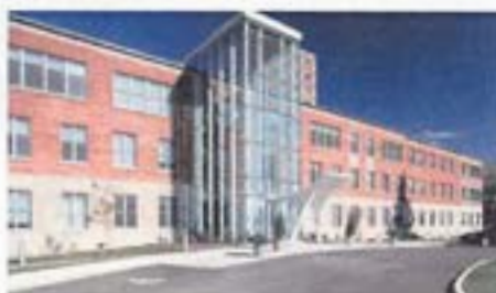
Fig. 221. Carrefour Providence implanté sur la proximité des Soeurs de la Providence aux abords de la rue Grenet (Source: ICB, Communauté Catholique)
