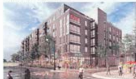
Fig. 259. Immeuble à logement multiple mixte (habitation/commerce), Chicago, États-Unis (Source: McCarthy Architecture)
