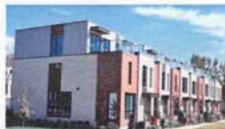
Fig. 248 Maisons de ville de 3 étages, la-des-Sœurs, Montréal (Source: Probert)
