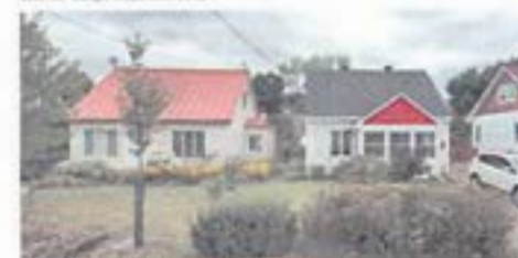
Fig. 111 Rue Stanislas, Quartier Norvick (Source: Google Maps)
