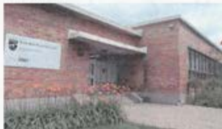
Fig. 225. École Bois-François-Aquarelle implantée sur la rue de Londres à proximité de la rue Grenet (Source: Louis Saint-Laurent)
