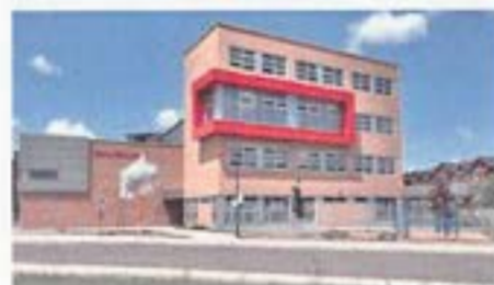
Fig. 251 École du Trésor-du-Bois, 4 étages, Saint-Laurent, Montréal (Source: Gagné)
