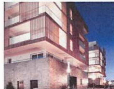
Fig. 266 Façade mêlant maçonnerie et bois, Montpellier, France (Source: Willmann)
