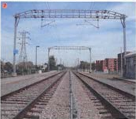
Fig. 10. Gare Bois-Franc. (Source : Photos de la gare)
