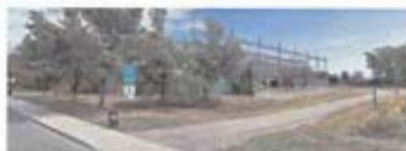
Fig. 90 Emprise d'Hydro-Québec et poste REED (Source: Streetscan, Août 2016)
