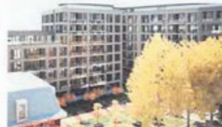
Fig. 257 Immeuble à logement multiple, Rosemont, Montréal (Source : Perle Convent)
