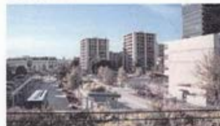
Fig. 291. Verdouement des espaces fonctionnels extérieurs, Station Rueil, Paris, France (Source: Urbisud)
