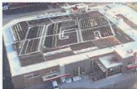
Fig. 190 Toiture commerciale où l'on pratique l'agriculture urbaine, Anandissement Saint-Laurent, Montréal (Source: Gehl/Hughes)
