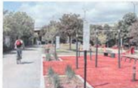
Fig. 196. Piste multifonctionnelle ponctuée d'espaces récréatifs, piste Des Canadiers, Montréal (Source: Toronto Transit Commission)
