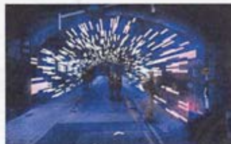
Fig. 216 Mur et plafond de viaduc piéton avec bandes lumineuses intermittentes, Doe Mi Mae 2in Tunnel, Heerle, Pays-Bas (Source: Arcojet)
