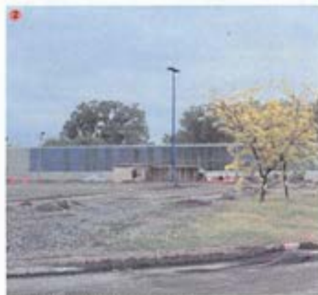
Fig. 5. Station du REM Bois-Franc en construction. Source : Shutterstock
