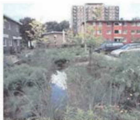
Fig. 301 Nœud paysagère en bordure d'un stationnement de surface, Habitations Jeanne Mance, Montréal (Source: Habitat100)
