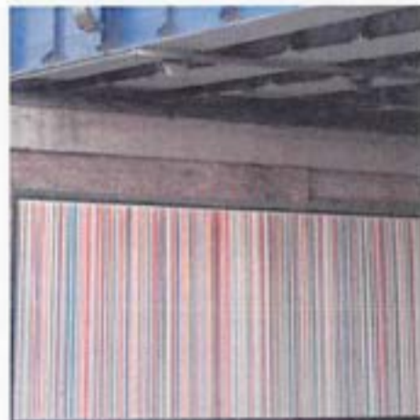
Fig. 217. Intervention artistique sous un viaduc, Londres, Royaume-Uni (Source: Bureau)
