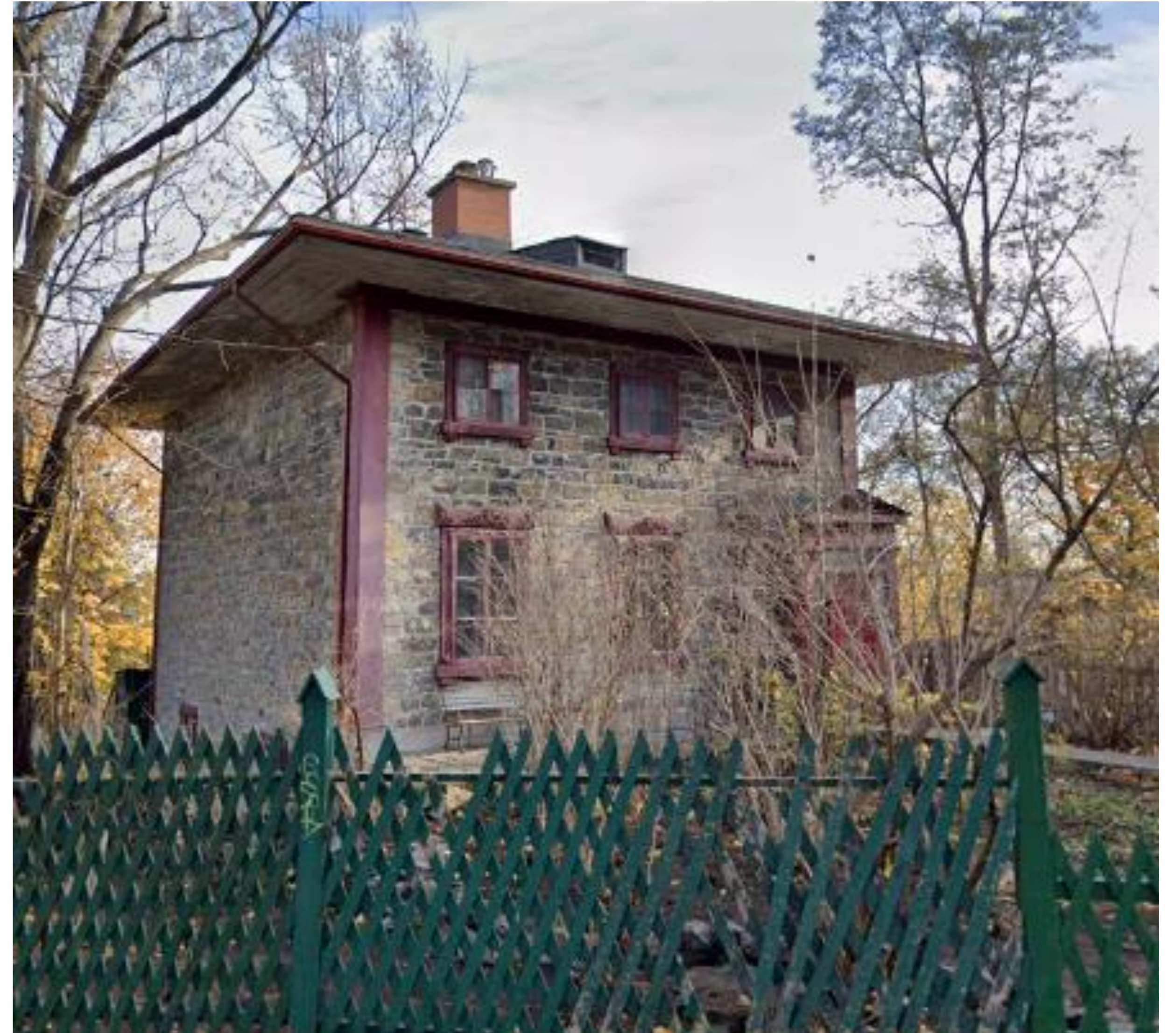
Façade avant, photographie, 2021
