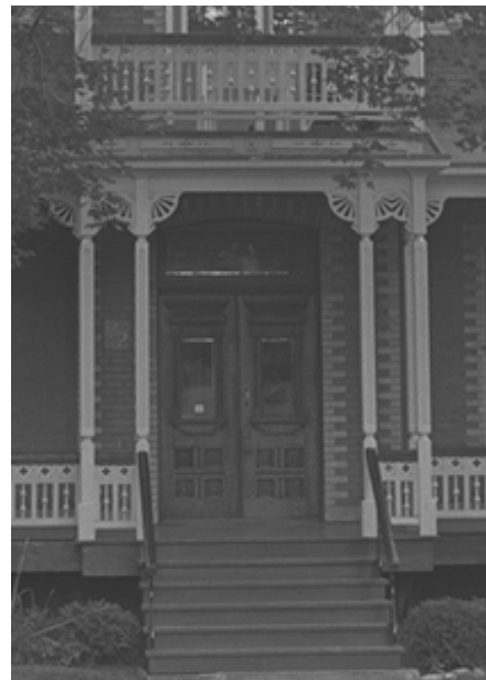
Les détails des boiseries extérieures tels que les colonnes de bois, les balustres et le tarabiscotage, contribuent au caractère d'un bâtiment.
