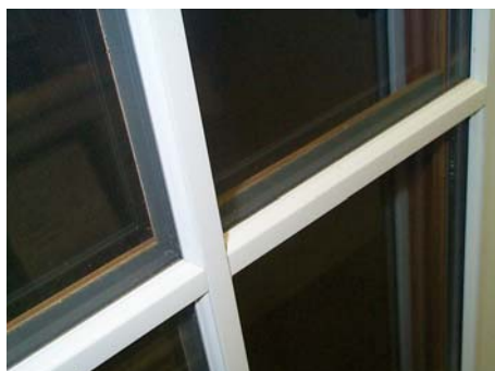
Les fenêtres à carrelage de surface (SDL) sont des fenêtres qui présentent des appliqués sur les deux parois d'un verre isolant afin de recréer l'effet de carreaux individuels. Ces fenêtres comprennent généralement des intercalaires dans le verre entre les meneaux.
