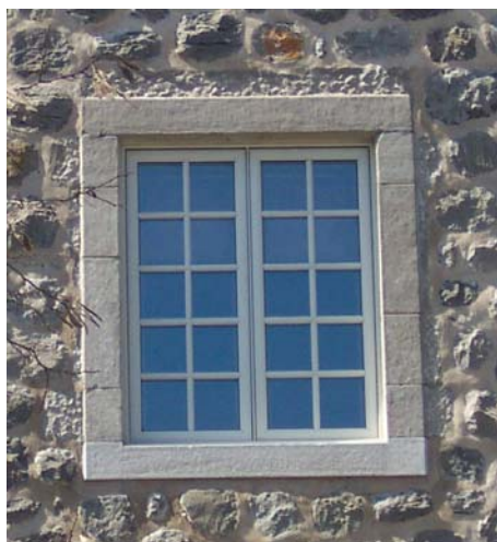
Les fenêtres à carrelage de surface (SDL) sont des fenêtres qui présentent des appliqués sur les deux parois d'un verre isolant afin de recréer l'effet de carreaux individuels. Ces fenêtres comprennent généralement des intercalaires dans le verre entre les meneaux.
