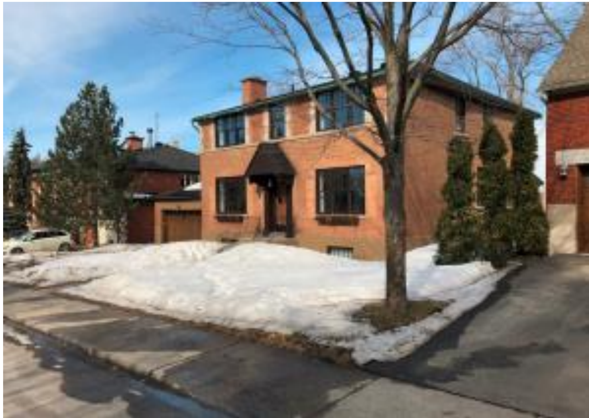
Façade avant et latérale / Front and side façade
