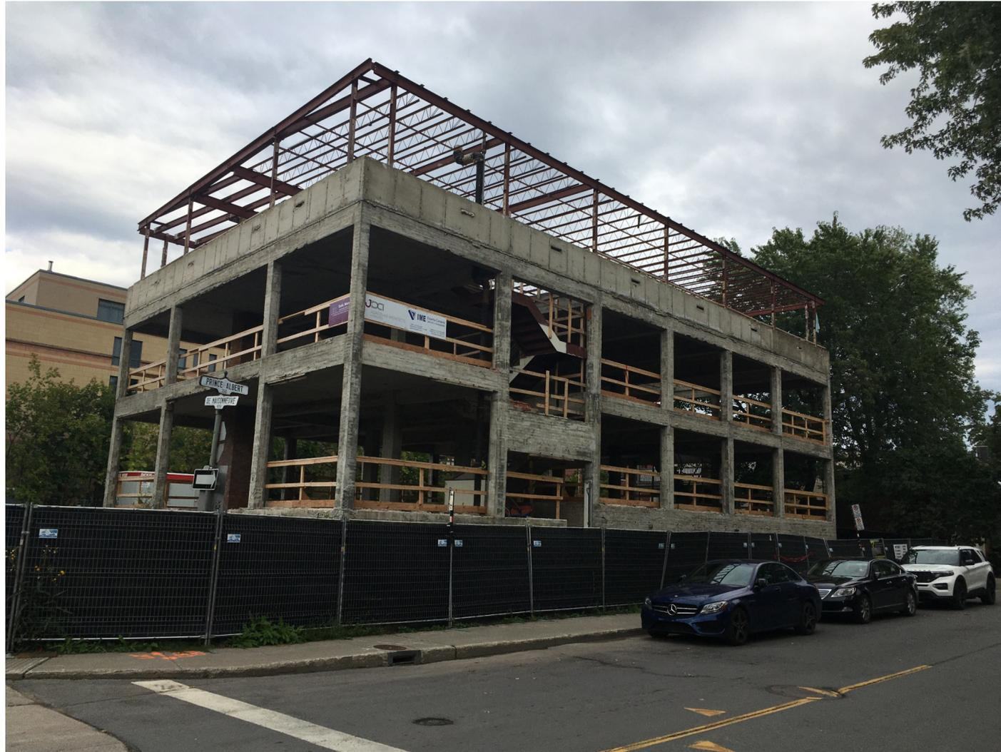
En vertu du Plan d'implantation et d'intégration architecturale (PIIA) qui a été approuvé, moins de 50% des murs extérieurs et de la toiture du bâtiment devaient être démolis. Toutefois, au moment des travaux, il a été constaté que l'enveloppe du bâtiment était endommagée et plus de 50% de celle-ci a été démolie.
