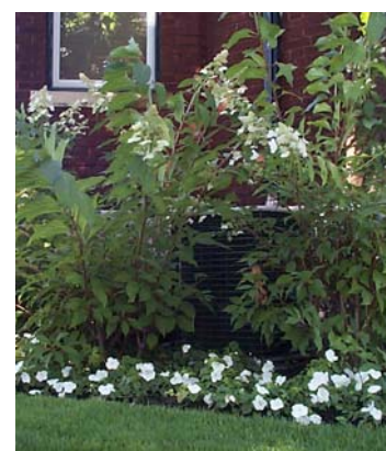
Les pompes à chaleur doivent être dissimulées derrière la plantation de façon à minimiser l'impact visuel, tel qu'illustré sur la photo du bas.
