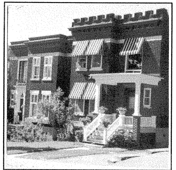
Côté ouest de l'avenue Lansdowne: toits plats, ressauts, bandes en pierre et porches.
