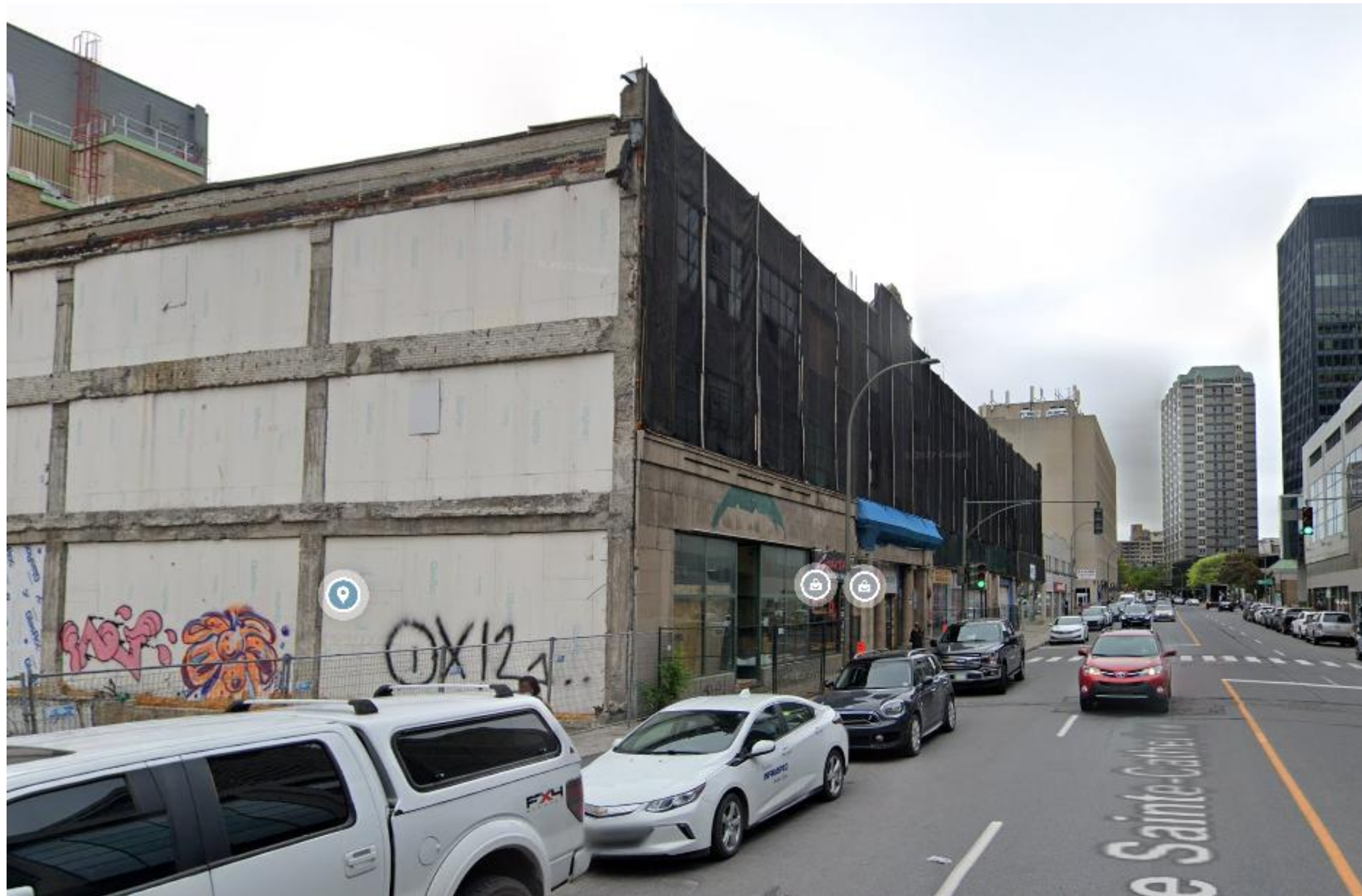
Façade avant et latérale | Front and side façade
