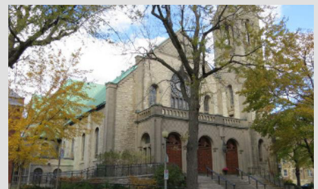
Mur ouest et façade Photo : Bergeron Gagnon inc.
