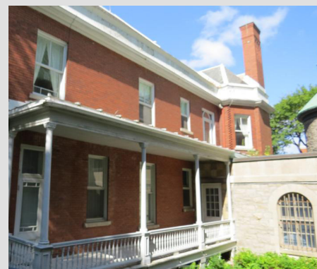
Élévation latérale du presbytère et fin du chemin couvert
